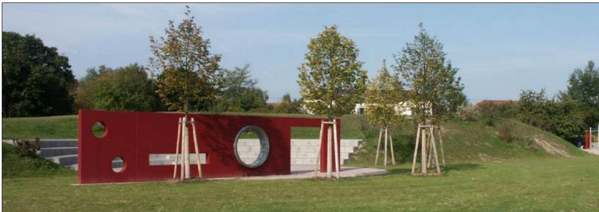
Abbildung 5.25: Kies-Wasser Erdbecken in Eggenstein. Bildquelle: Universität Stuttgart, Institut für Gebäudeenergetik, Thermotechnik und Energiespeicherung.
