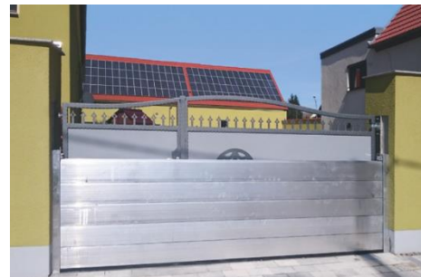
Mobiler Hochwasserschutz mit Dammbalken Hochwasserschutzfibel, 2022
