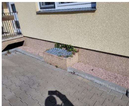
Konstruktive Erhöhung von Lichtschächten
