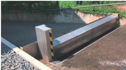
Mobiles Klappschott ([www.klappschott.de](http://www.klappschott.de))
