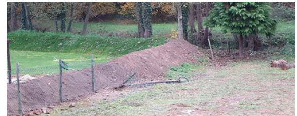
Verwallung / Mauern BCE, www.hochwassermanagement.rlp-umwelt.de
