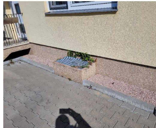
Konstruktive Erhöhung von Lichtschächten
