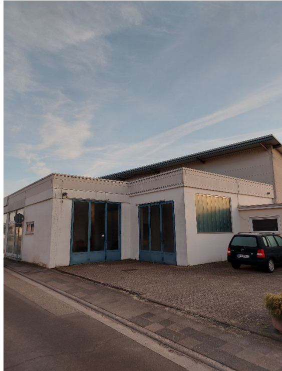
Abbildung 11 Attikablech an dem Bestandsgebäuden
