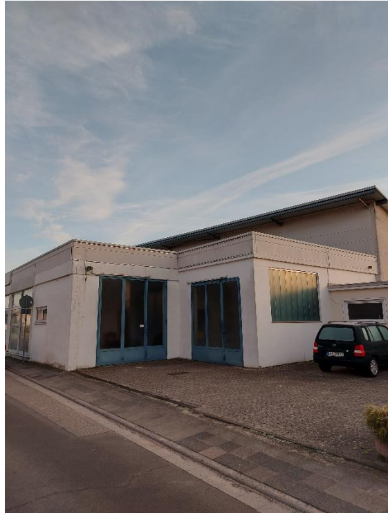
Abbildung 9 Attikablech an dem Bestandsgebäuden
