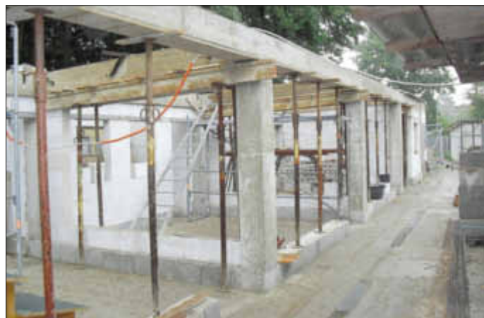
Abschluss der Schal- und Betonierarbeiten
